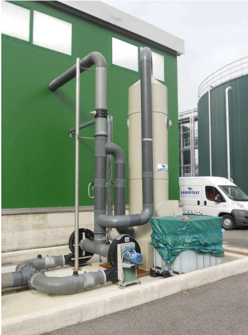
Impianto scrubber da 2.500 m<sup>3</sup>/h con sistema di bypass elettropneumatico.
