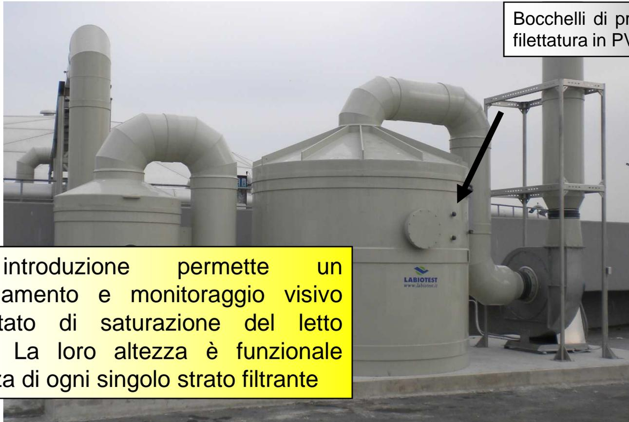
Bocchelli di prelievo DN80 con filettatura in PVC.
