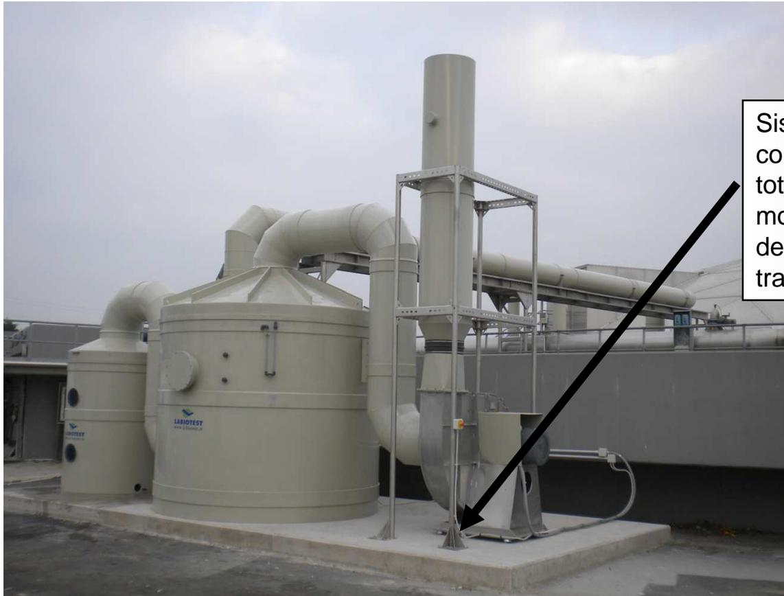
Sistema ventilante modulante con inverter e di pressione totale in grado di garantire il moto ideale di attraversamento dell'effluente oggetto del trattamento.
