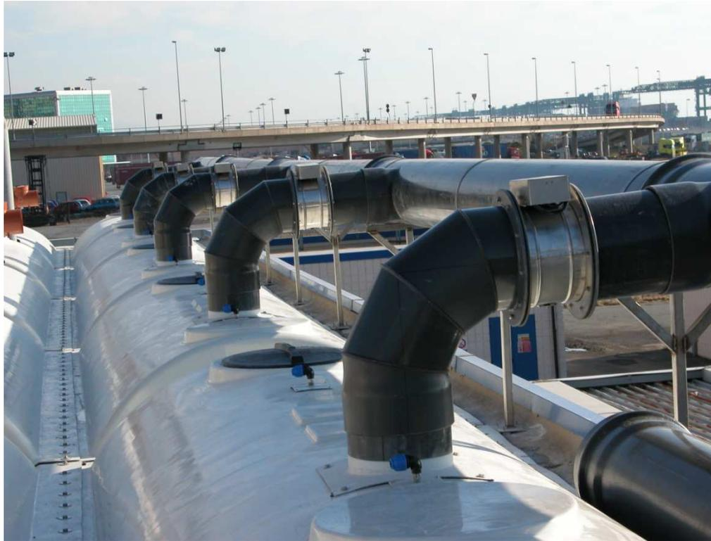
Particolare: sistema aeraulico in PVC con serrande elettrocomandate e sistema di coperture in PRFV
