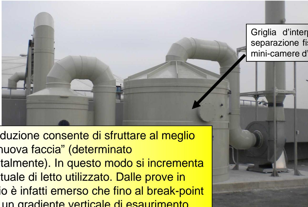
Griglia d'interposizione per la separazione fisica del letto con mini-camere d'espansione
