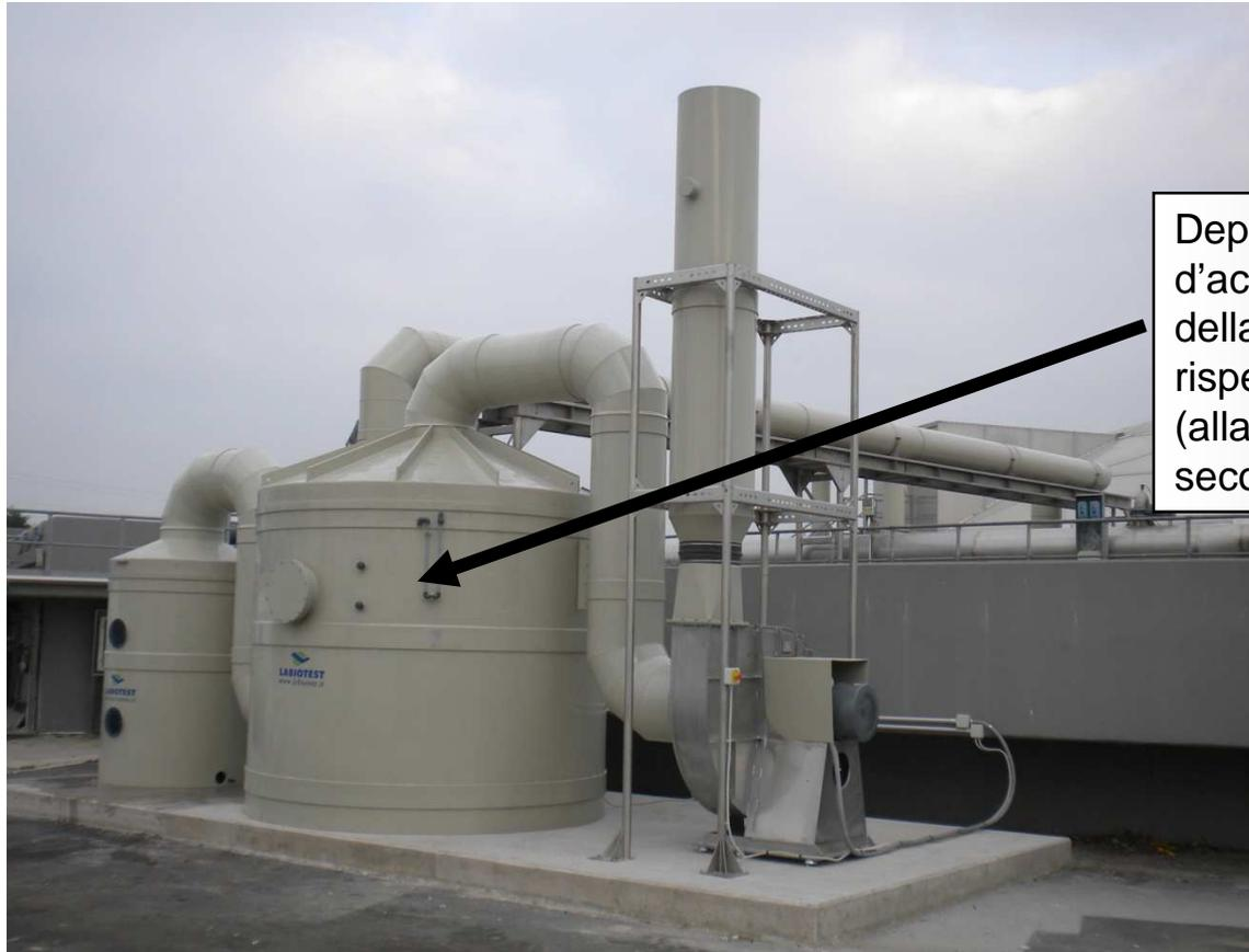
Deprimometro a colonna d'acqua per il monitoraggio della caduta di pressione rispetto alla pressione esterna (allarme anti-implosione secondario)
