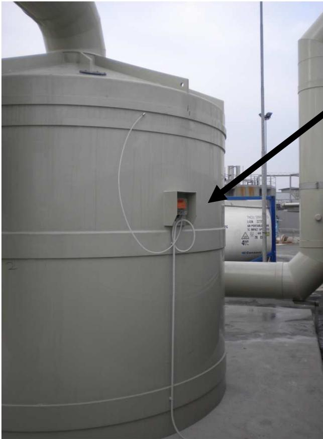
Misuratore di pressione differenziale per la determinazione del carico totale del sistema (allarme anti-implosione) o delle perdite di carico del letto filtrante
