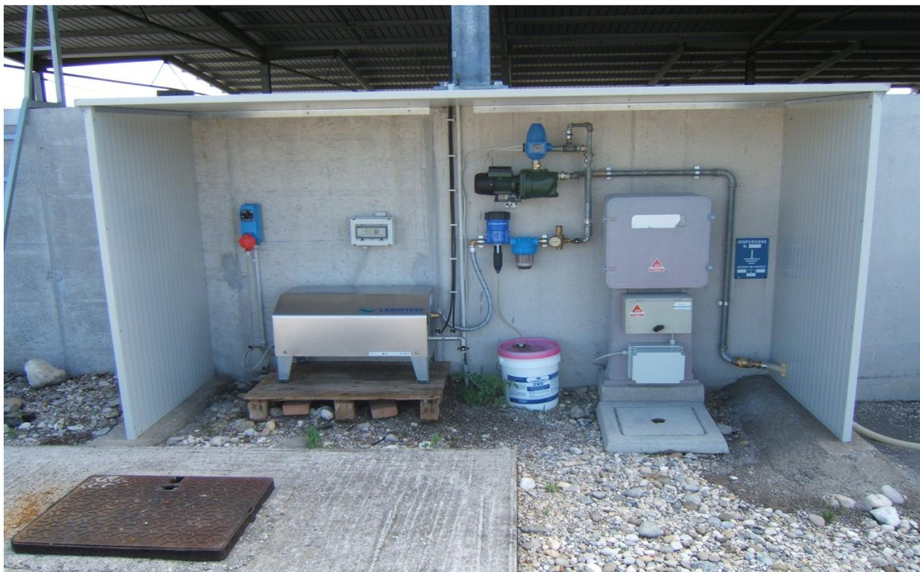
Sistema di nebulizzazione per il trattamento odori presso la sezione di affinamento fanghi
