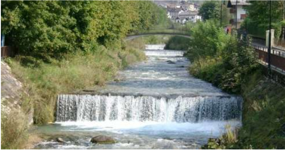
Fig. 3.8.4 - Esempio di briglia lungo un corso d'acqua
